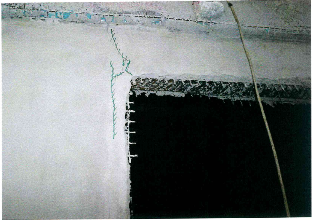
Рисунок 25 - Состояние образца после испытаний
