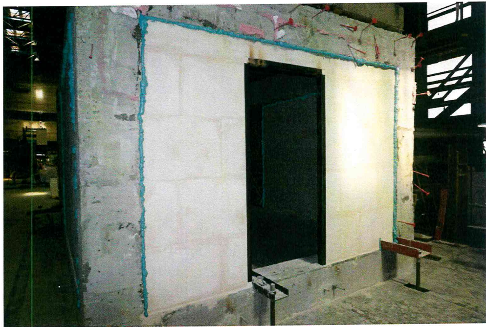
Рисунок 17 – Заполнение зазоров монтажной пеной
