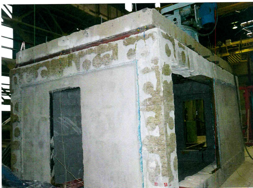
Рисунок 24 - Состояние перегородок до испытаний
