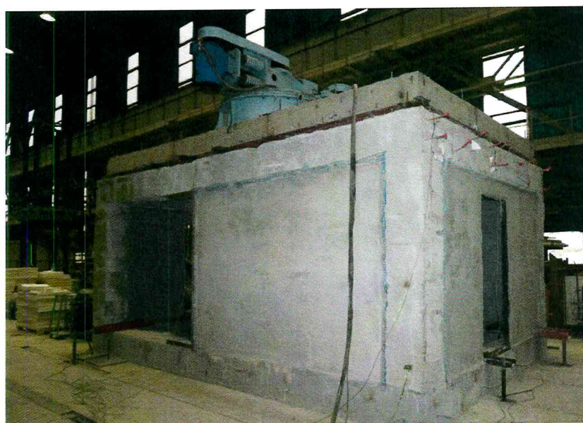
Рисунок 22 - Состояние перегородок до испытаний
