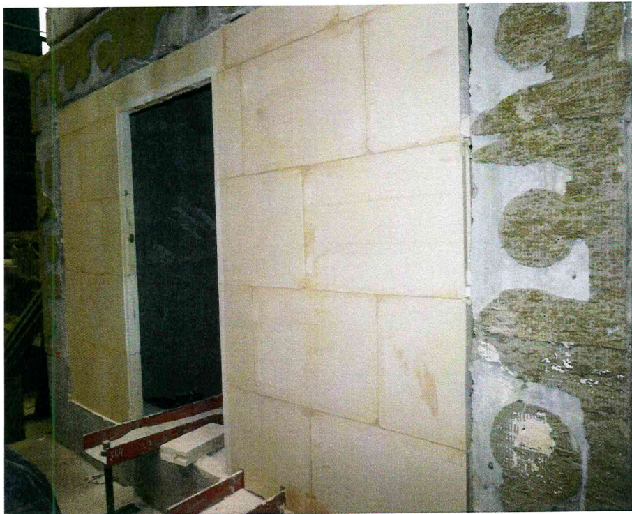
Рисунок 15 – Возведение перегородок
