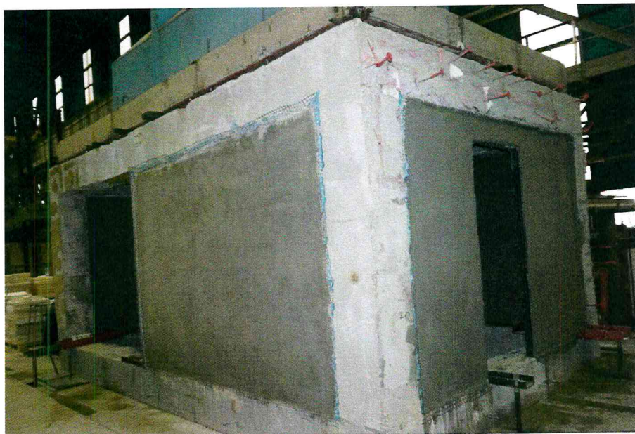
Рисунок 21 – Оштукатуривание перегородок
