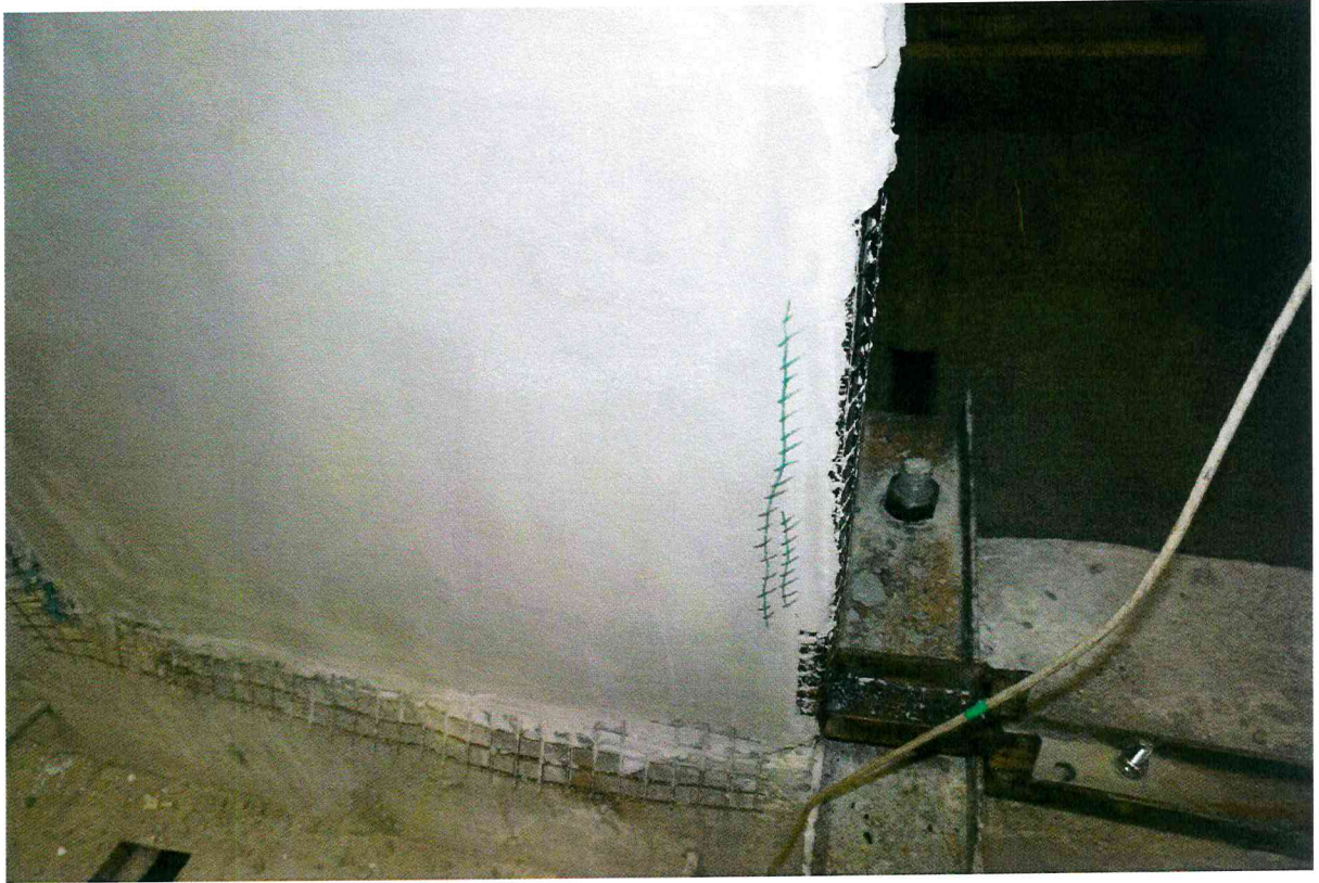
Рисунок 31 - Состояние образца после испытаний
