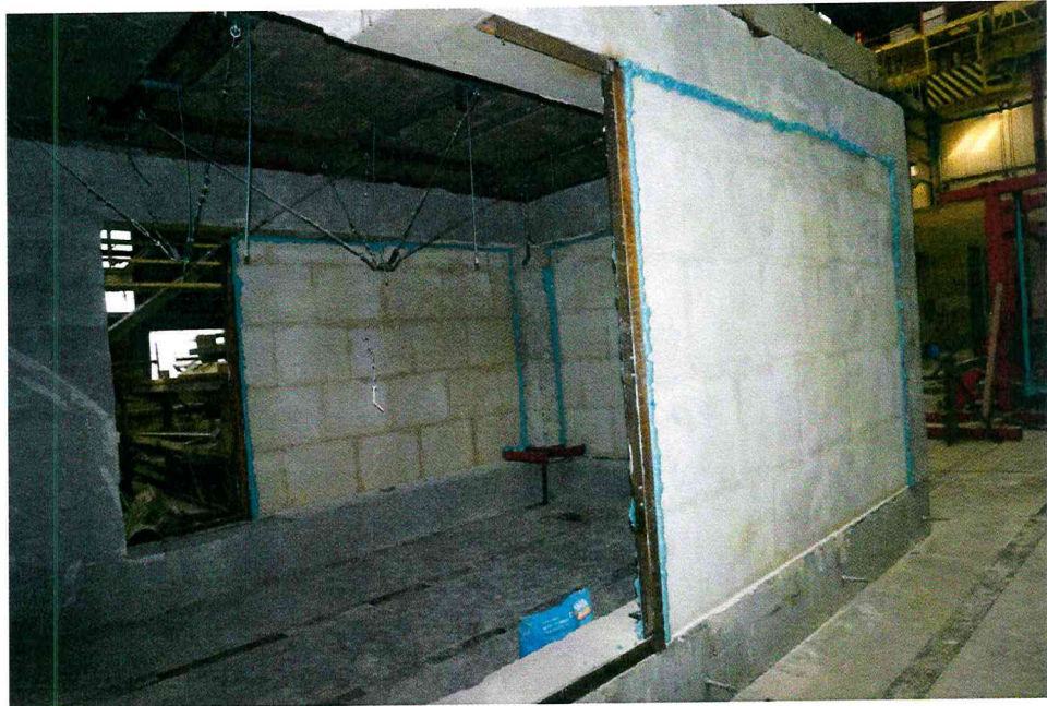
Рисунок 16 – Заполнение зазоров монтажной пеной
