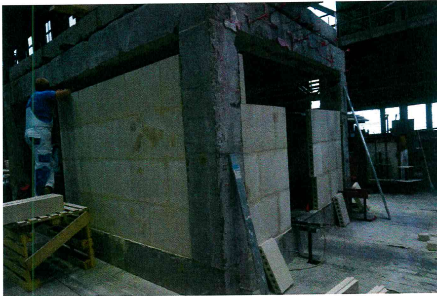
Рисунок 14 – Возведение перегородок
